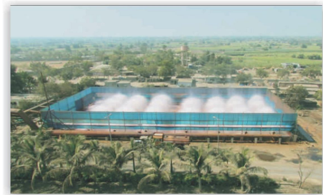
Sistema de enfriamiento de la niebla del tipo de Louver
